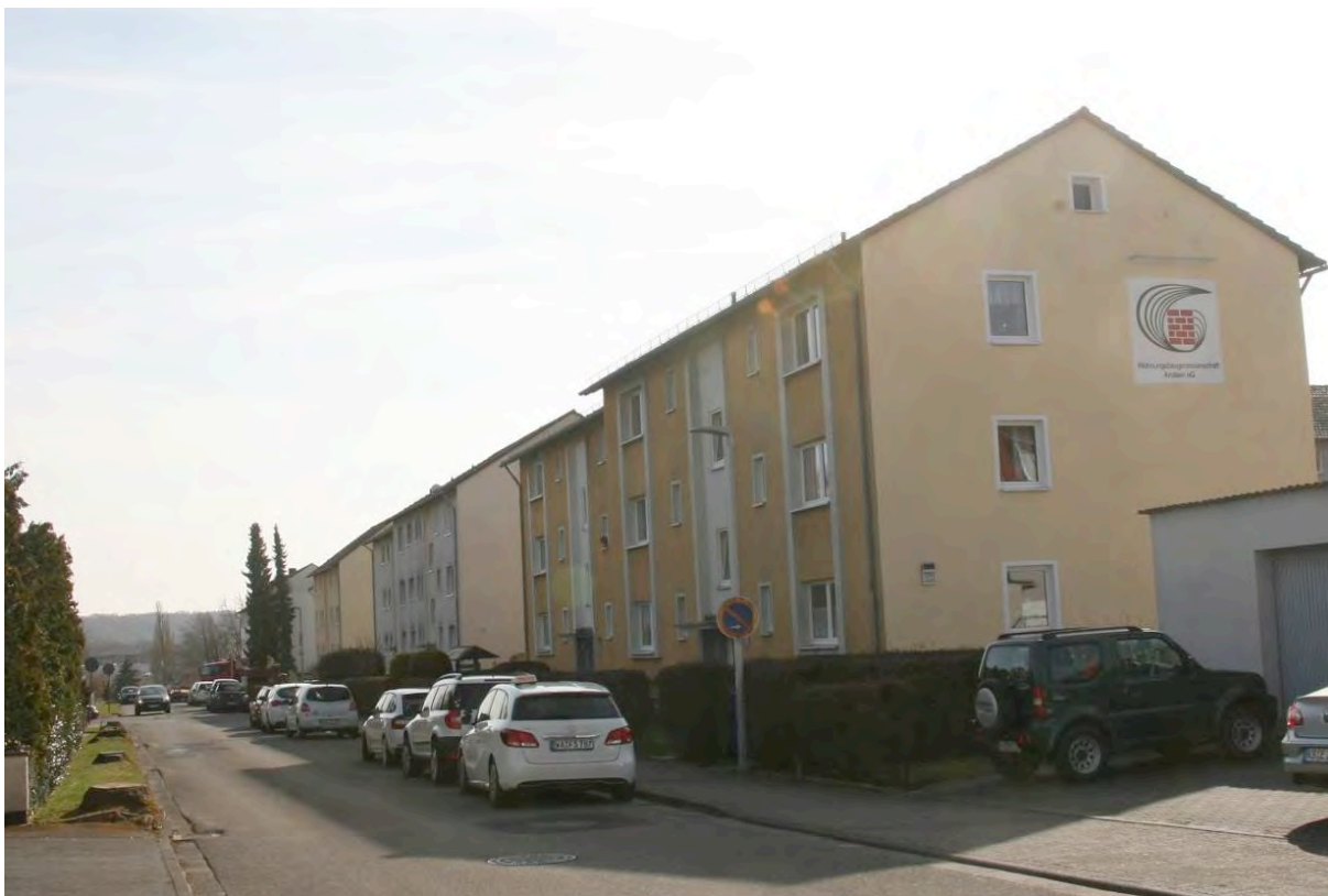
Abbildung 22: Teilbereich 6, Sanierungsbedarf in der Wilhelm-von-Humboldt-Straße Quelle: eigene Darstellung
