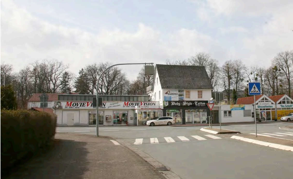
Abbildung 5: Teilbereich 1, städtebauliche Mängel Kreuzungssituation Wetterburger Straße Quelle: eigene Darstellung
