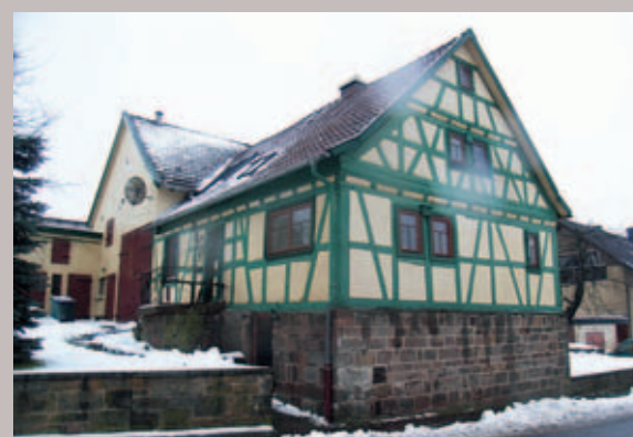
Natursteinsockel eines giebelständigen Hauses in der südlichen Rhön
