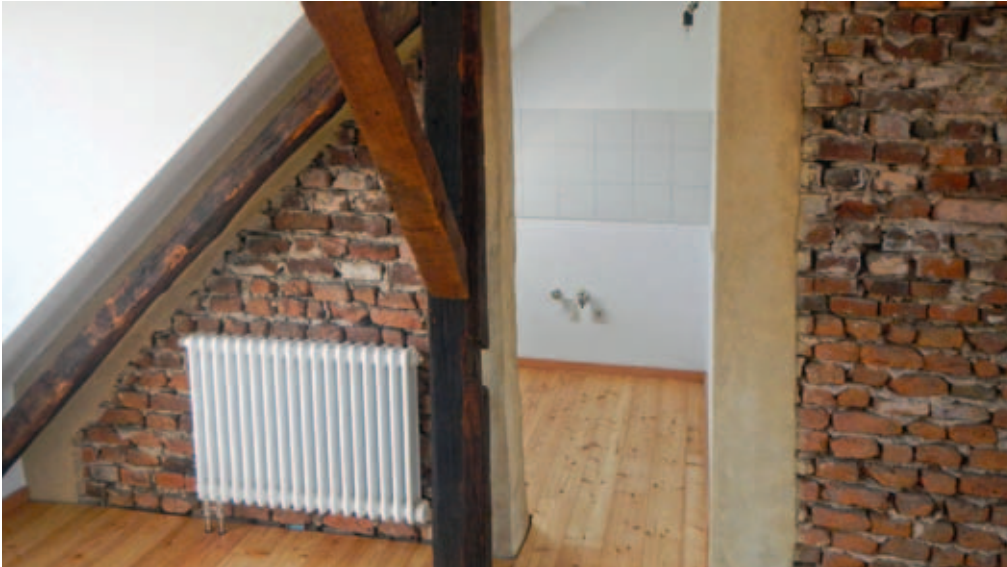
Wiederwendung alter Backsteine bei einem Dachausbau
