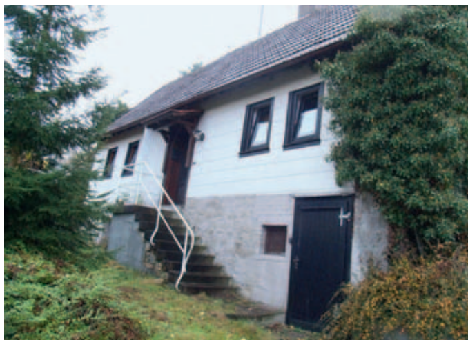
Außenverschalung herunterge- zogen bis Unterkante Keller- dämmung (vorher/nacher)
