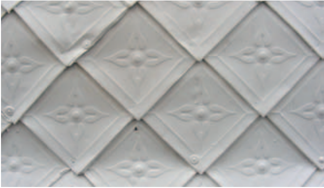
Blechverkleidung im westlichen Hessen
