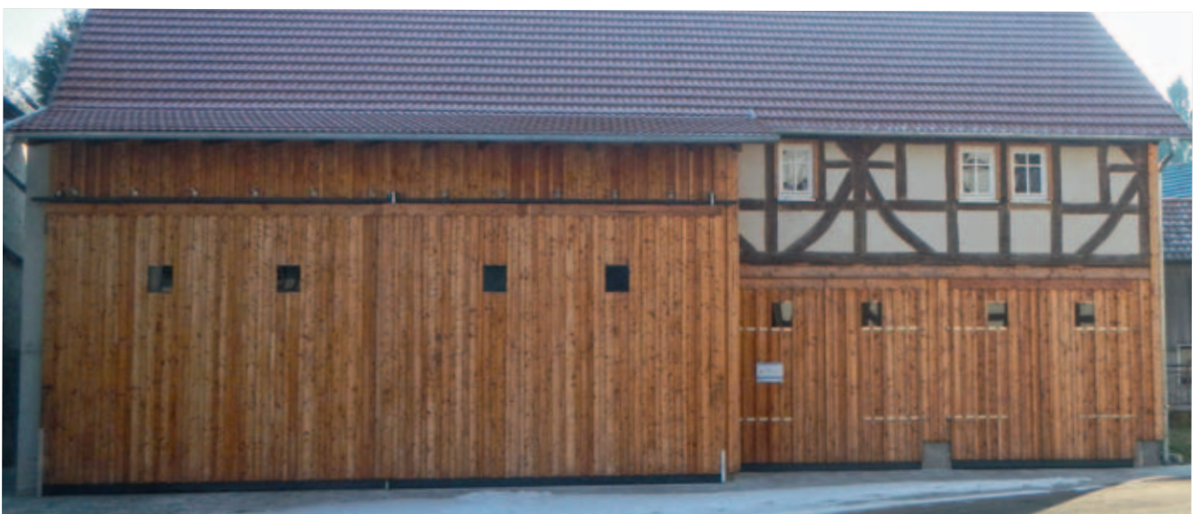
Landwirtschaftlicher Neubau inmitten eines Dorfes mit wiederverwendetem Fachwerk
