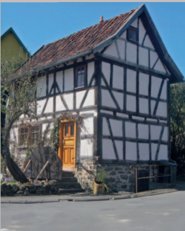
Kleines Hintersiedlerhaus im Schwalmthal
