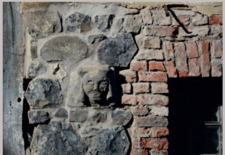
Greifenstein-Beilstein, Schalestein/Diabas mit Backsteingewände
