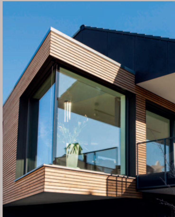
Neubau mit modernem Holzkerker (Atelier Spitzner)
