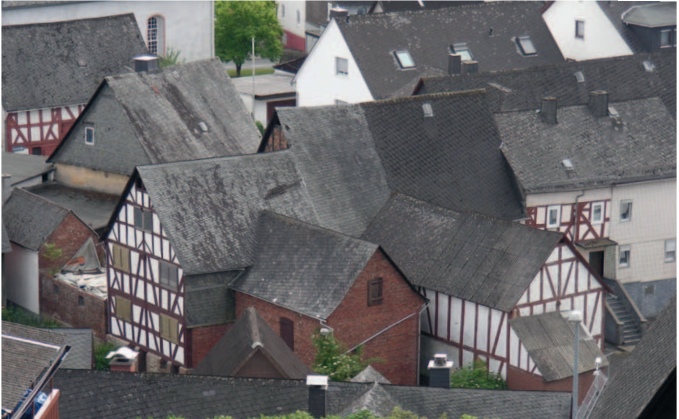
Schieferdächer im westlichen Hessen
