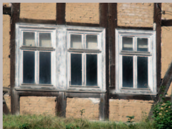
Fensterdrilling an einem barocken Fachwerkhaus
