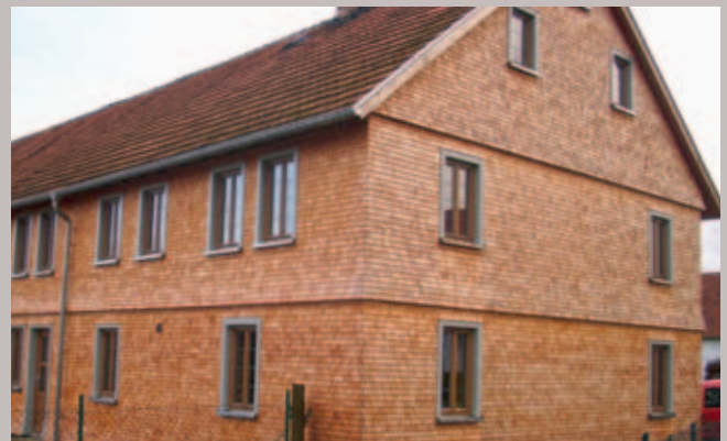
Lärchenholzschindeln an den Wetterseiten
