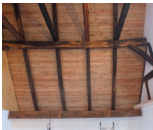
Dämmung der Dachschrägen von außen aufgedoppelt mit sichtbarem altem Dachstuhl
