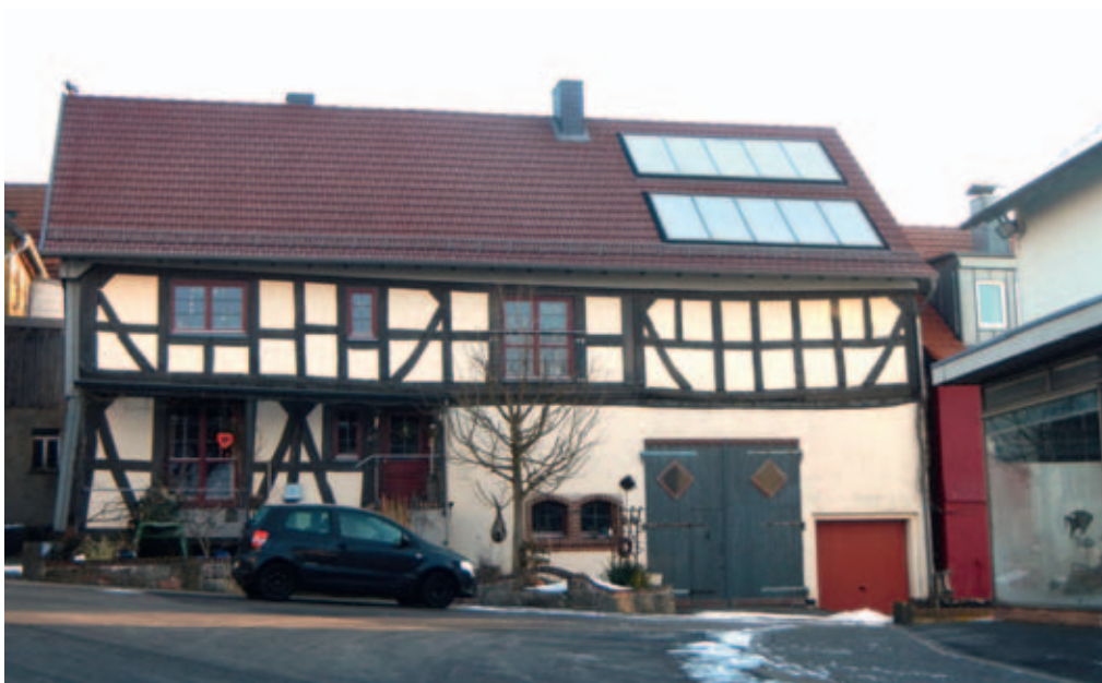
Fachwerkhaus mit Warmwasserkollektoren
