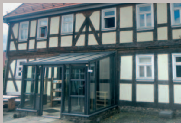
Schlichter Windfang an einem Kulturdenkmal in Hopfmannsfeld
