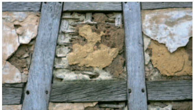
Altes Fachwerk mit Lehmfüllung
