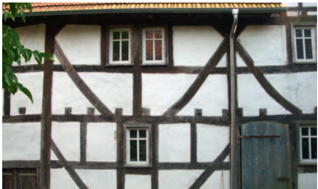
Fenster- und Torverteilung bei einem Fachwerkhaus in Nordhessen
