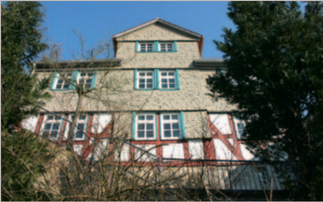
Beispiel einer Schindelverkleidung aus Nordhessen
