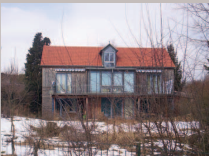
Neubau eines Holzhauses (Architekt Josef Michael Ruhl)
