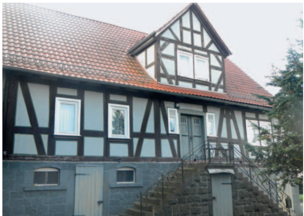
Den Eingang betonender Dachaufbau in Mittelhessen als spätere Hinzufügung
