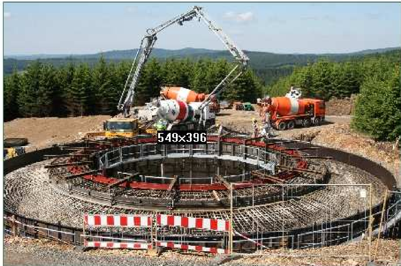
Der Guss des Fundaments der Anlage Nr 4
