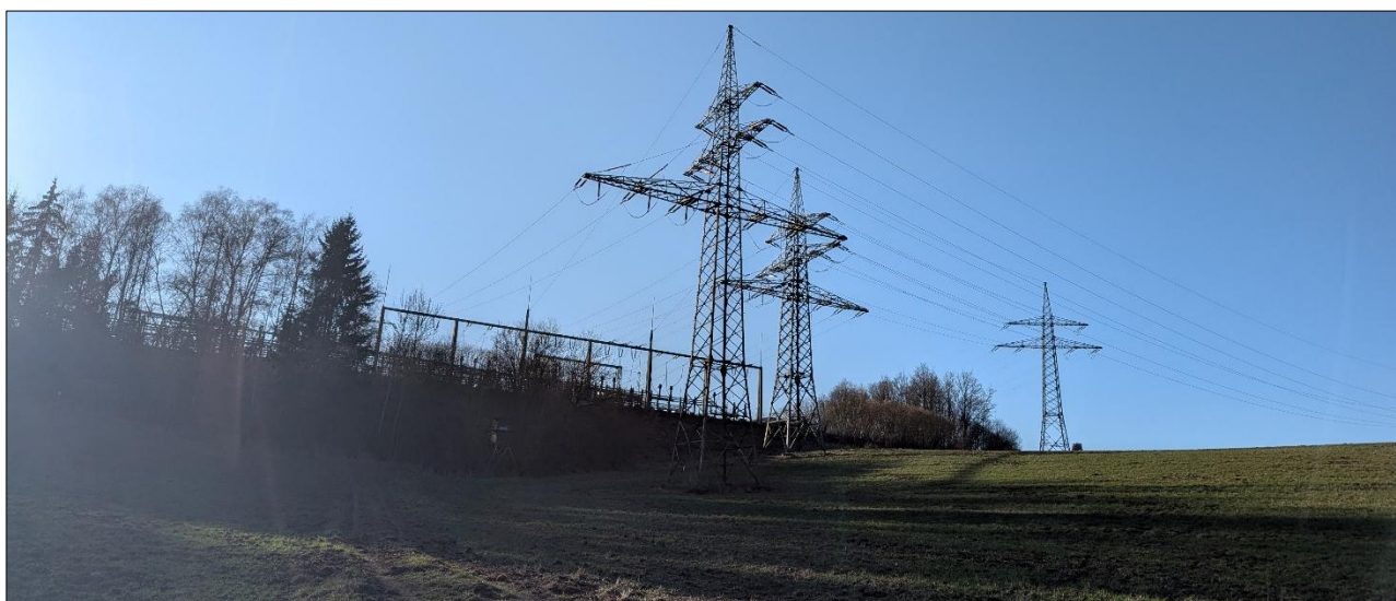
Abbildung 5: Aktuelle Aufnahme des Plangebietes, Blick auf die Strommasten und Freileitungen
